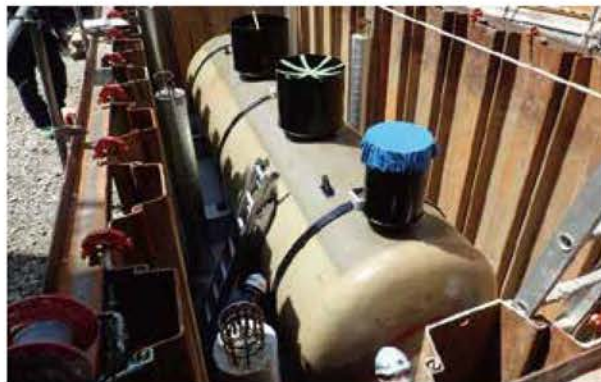
◀地下タンクの据え置き工事
