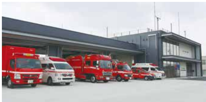
▲新築された津市北消防署の車庫棟(手前)と事務所棟(後方)
