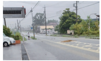
▲消防本部周辺での道路冠水状況
